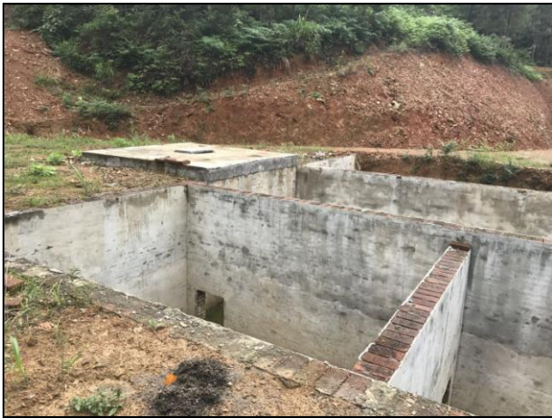
废水收集池及现有无害化处理池
