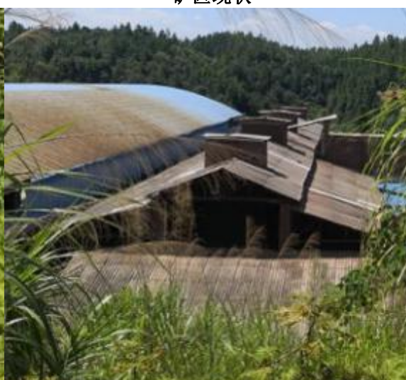
矿区西北侧砖厂
