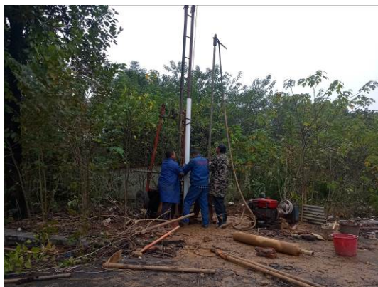
图 5.1.2.3-1 DX01 水文地质钻孔下管照片
