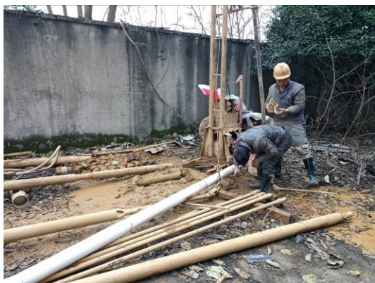
图 5.1.2.3-3 DX04 水文地质钻孔钻进照片
