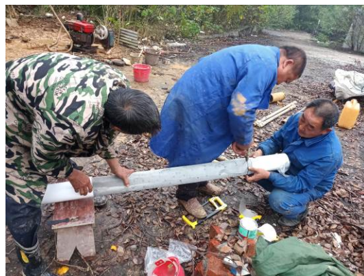
图 5.1.2.3-2 DX01 过滤管外包网照片
