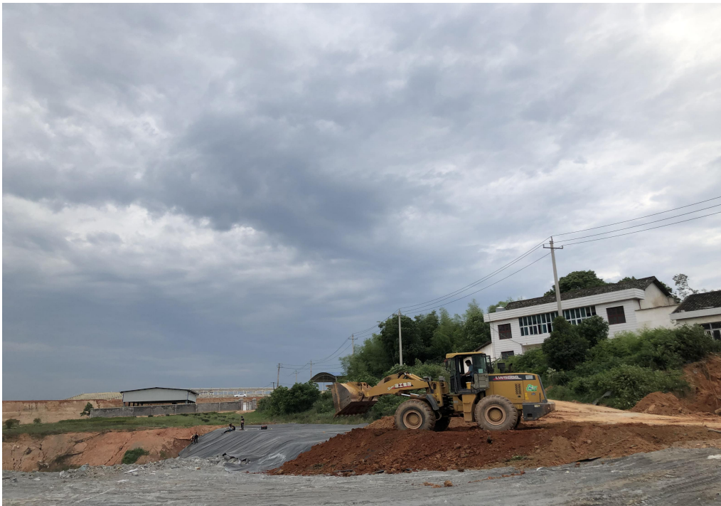
图5.2-3 填埋场顶部覆土
