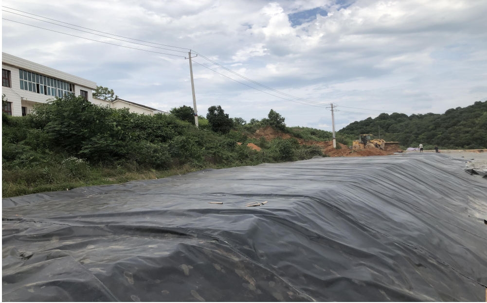
图5.2-2 填埋场顶部防渗
