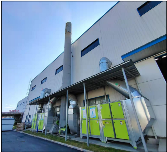
喷漆废气处理设施
