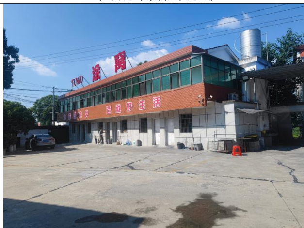
本项目北侧现状照片
