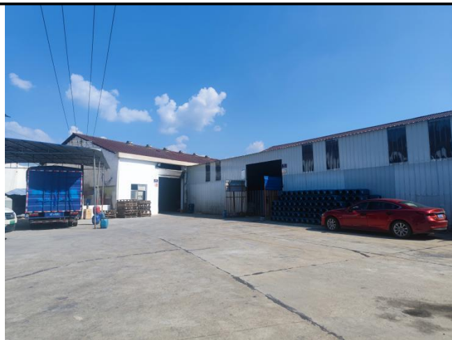
本项目东侧现状照片
