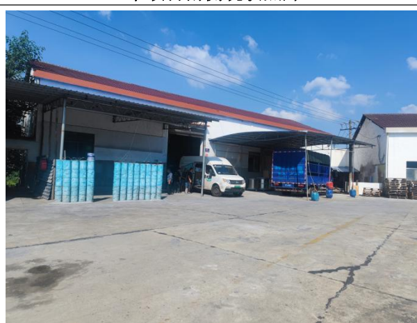
本项目西侧现状照片
